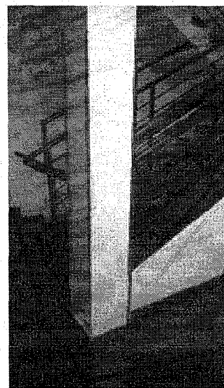
Figura 42 Instalação de cantoneiras, 4 cantos vivos do pilar
