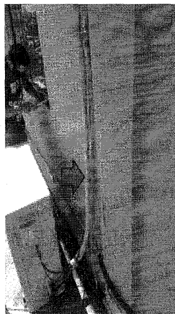
Figura 32 Readequação dos drenos
