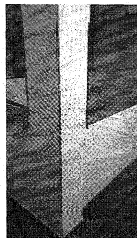
Figura 47 Instalação de cantoneiras, 4 cantos vivos do pilar
