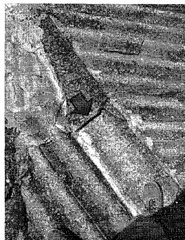
Figura 56 telhas danificadas
