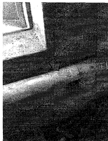
Figura 52 Junção fora de norma
