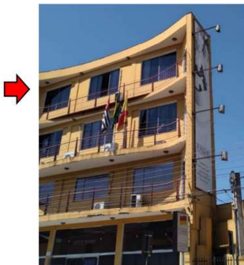
Figura 39 Remoção de luminárias do teto da sacada
