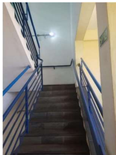
Figura 33 Escada que receberá intervenção
