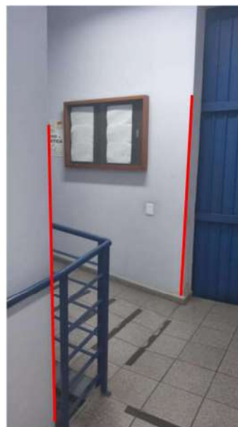
Figura 277 Térreo, instalação de cantoneiras
