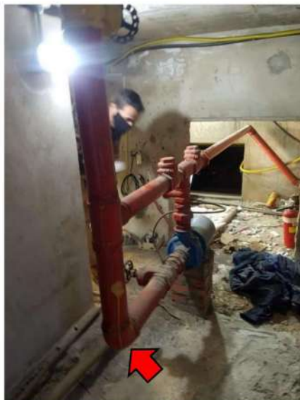
Figura 49 Ancoragem a ser feita
