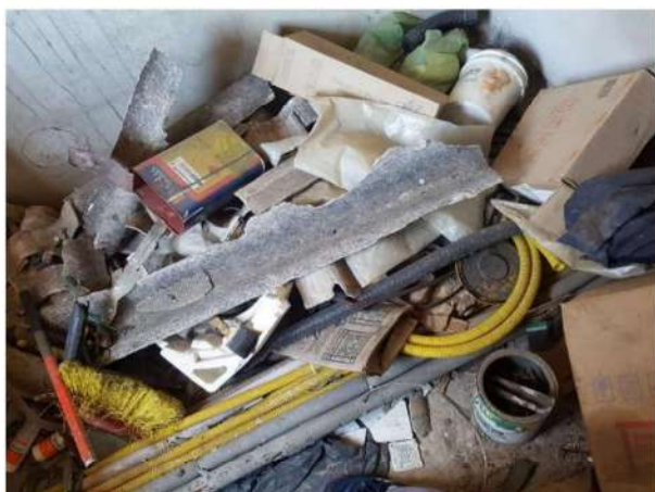
Figura 51 Remoção de entulho
