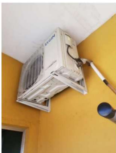
Figura 48 Realocação de condensadora
