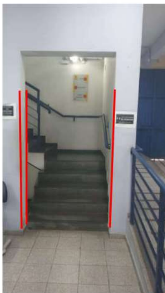
Figura 2626 Térreo, instalação de cantoneiras
