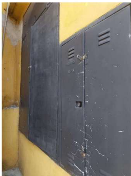
Figura 15 QDC renovar pintura
