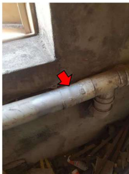
Figura 52 Junção fora de norma
