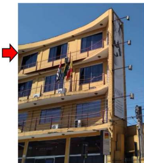
Figura 44 Remoção de luminárias do teto da sacada
