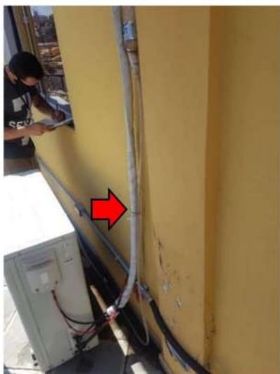
Figura 32 Readequação dos drenos
