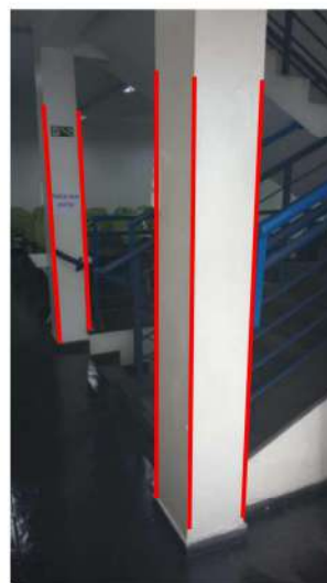
Figura 3530 Instalação de cantoneiras, 4 cantos vivos dos pilares
