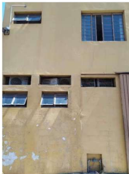
Figura 12 Apicoamento e tratamento da fachada
