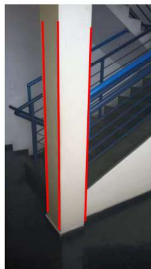
Figura 42 Instalação de cantoneiras, 4 cantos vivos do pilar
