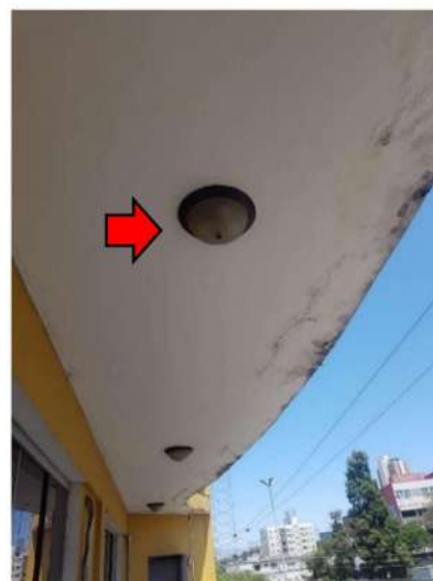
Figura 3129 Remoção de luminárias do teto da sacada
