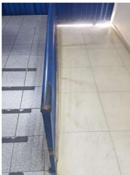
Figura 19 Pintura de corrimão
