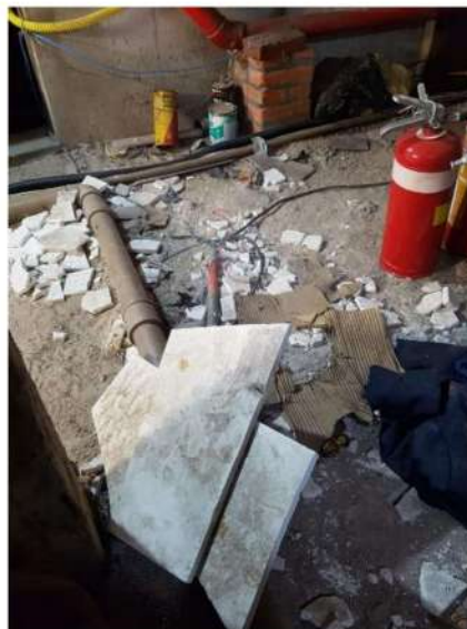
Figura 50 Remoção de entulho
