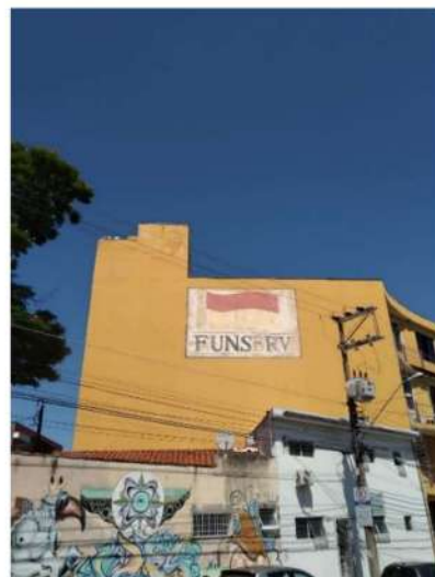
Figura 5 Foto in loco fachada lateral esquerda
