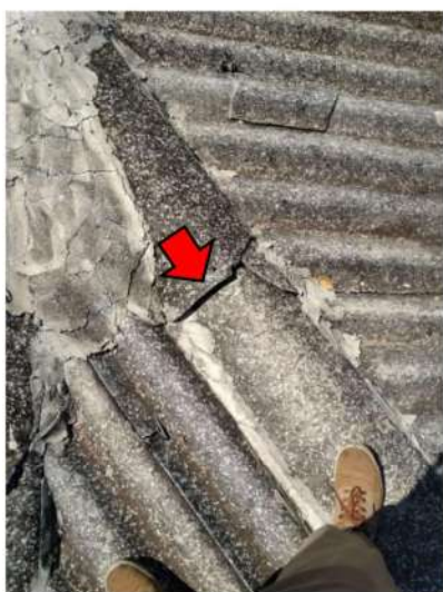
Figura 56 telhas danificadas
