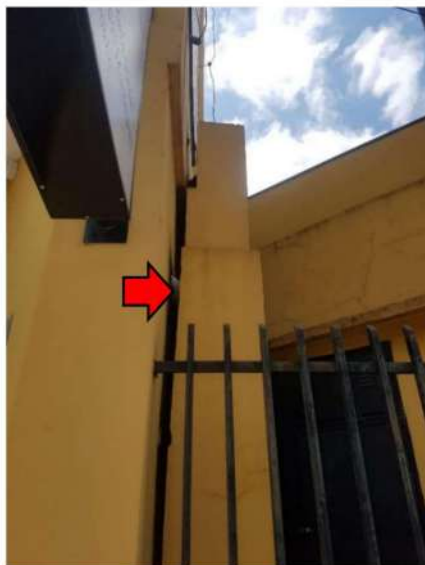
Figura 11 Caixa de telefonia
