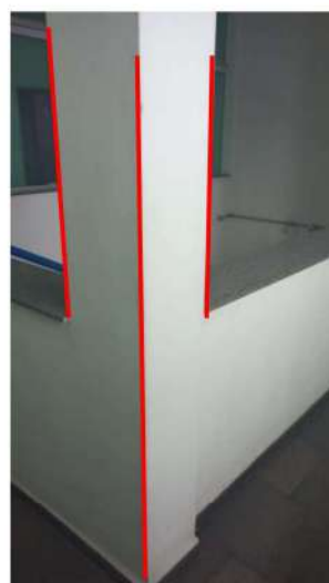
Figura 47 Instalação de cantoneiras, 4 cantos vivos do pilar
