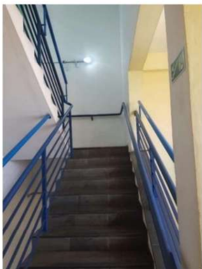
Figura 41 Hall da escada que receberá intervenção
