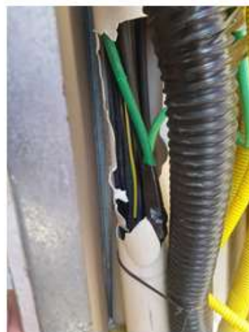
Figura 28 Condutores em tubo pvc , fora de norma
