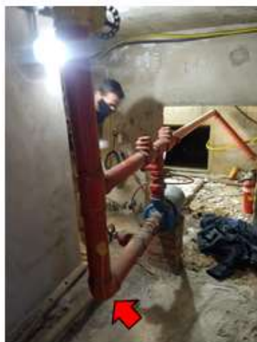
Figura 49 Ancoragem a ser feita
