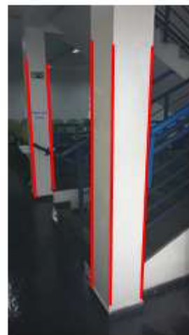
Figura 3530 Instalação de cantoneiras, 4 cantos vivos dos pilares
