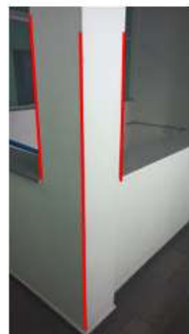
Figura 47 Instalação de cantoneiras, 4 cantos vivos do pilar
