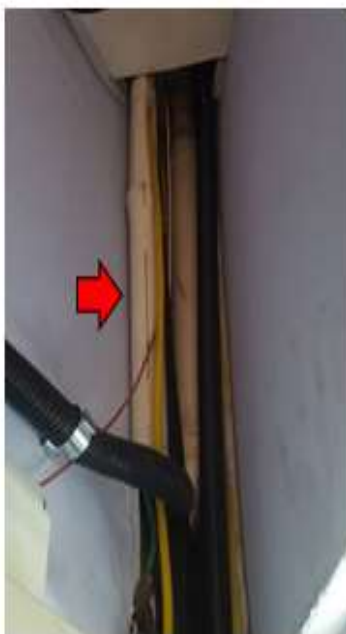
Figura 30 Condutores em tubo pvc, fora de norma
