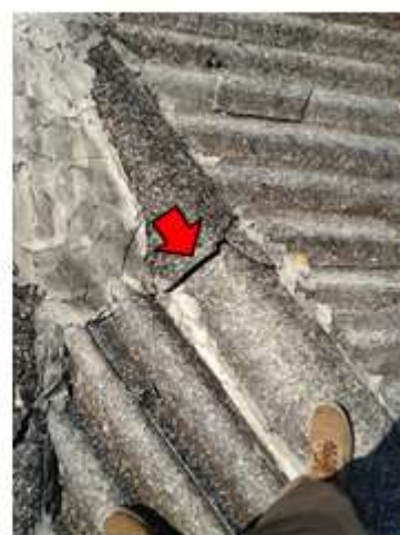
Figura 56 telhas danificadas
