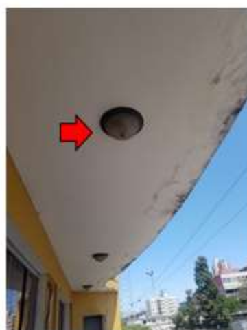
Figura 3129 Remoção de luminárias do teto da sacada
