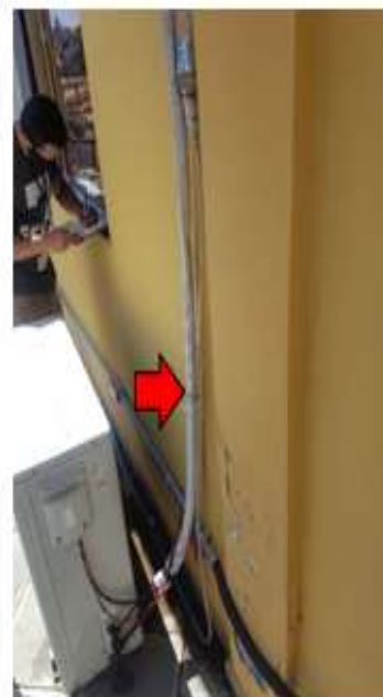
Figura 32 Readequação dos drenos
