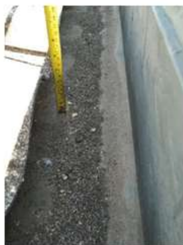
Figura 54 Calha com prof. abaixo do necessário
