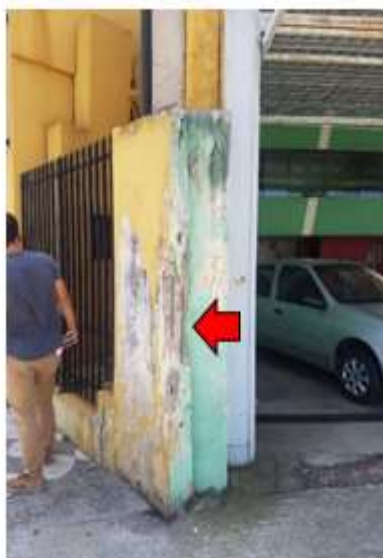
Figura 13 Armadura aparente na fachada
