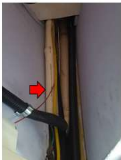
Figura 37 Cabos transportados fora de norma
