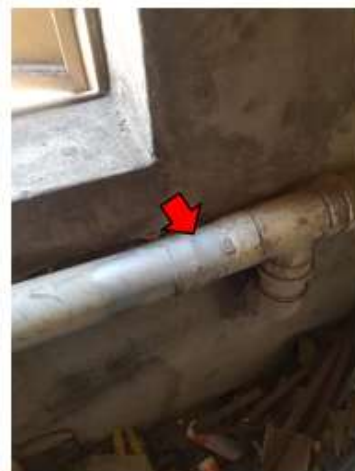
Figura 52 Junção fora de norma
