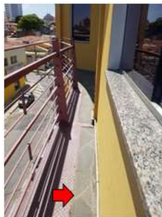
Figura 4631 Remoção de ardósia, tratamento da sacada e guarda corpo
