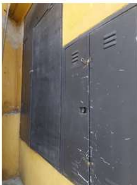
Figura 15 QDC renovar pintura
