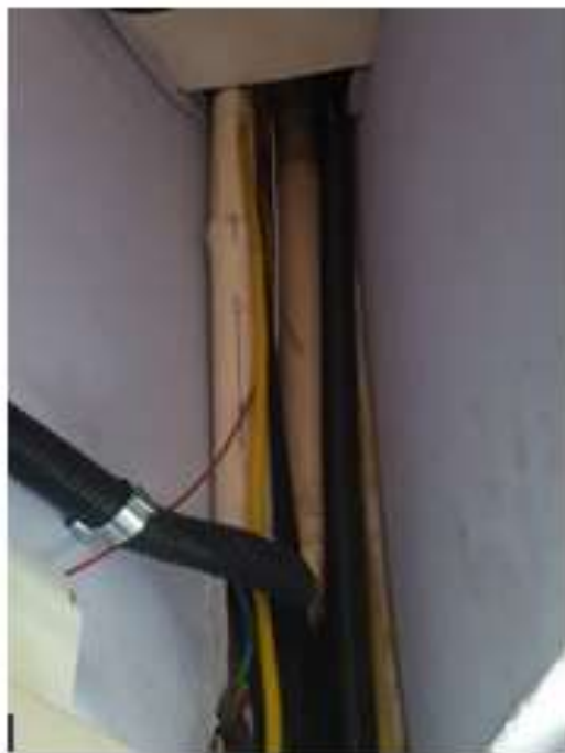
Figura 325 Condutores em tubo pvc, fora de norma
